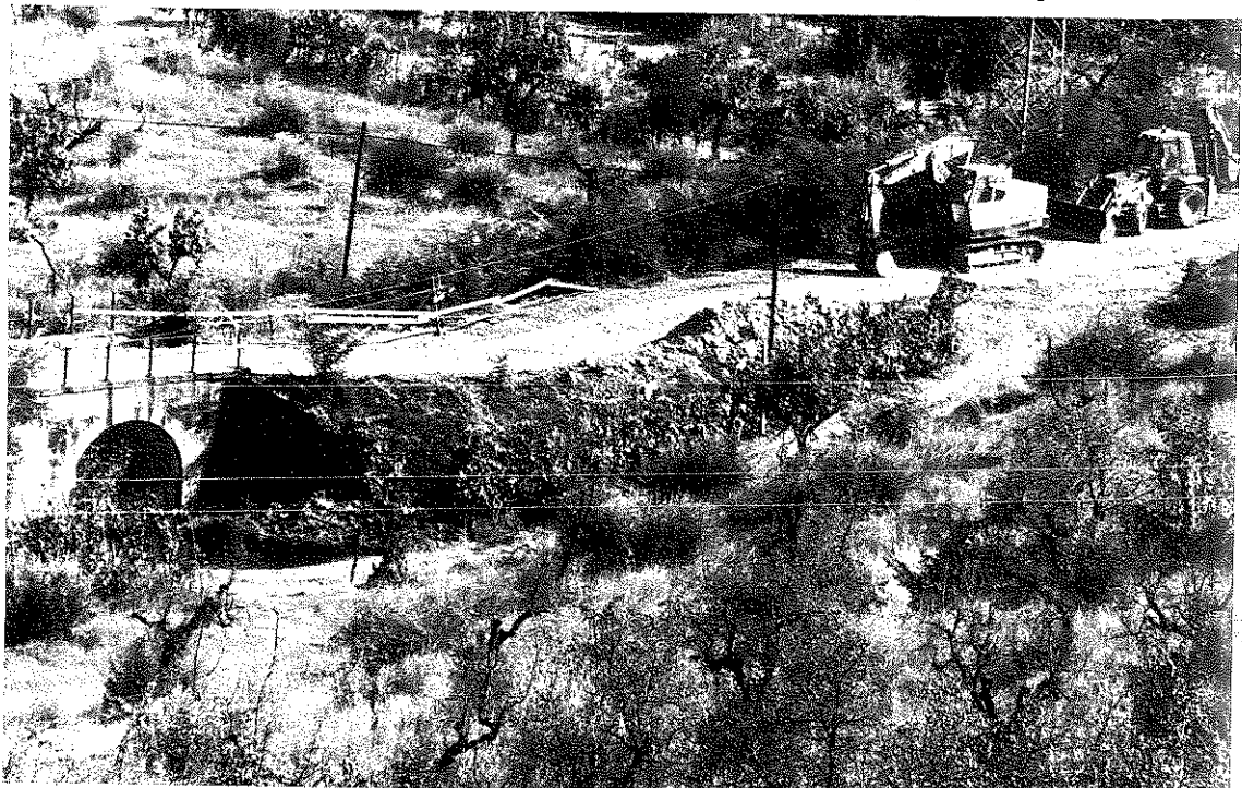
Lavori sulla Faentina (foto Caldari)
