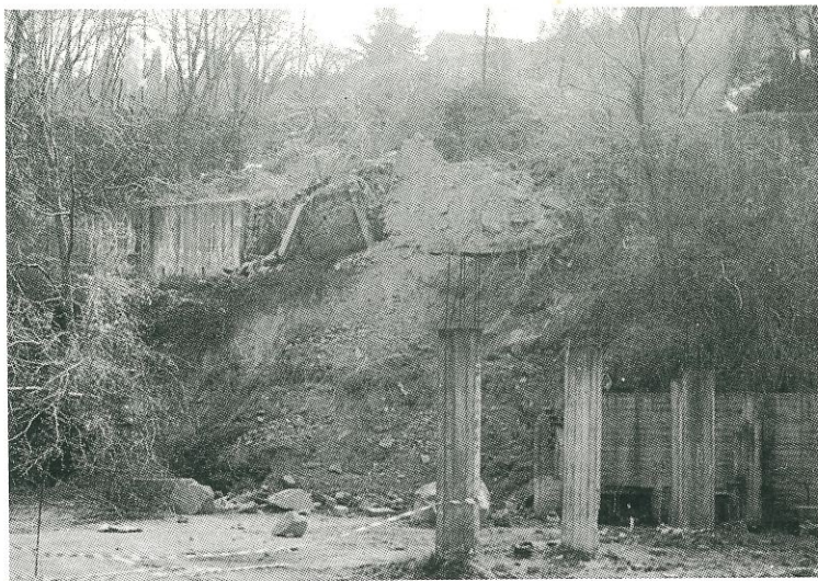
La zona interessata dal movimento franoso. (Foto Della Bella)
