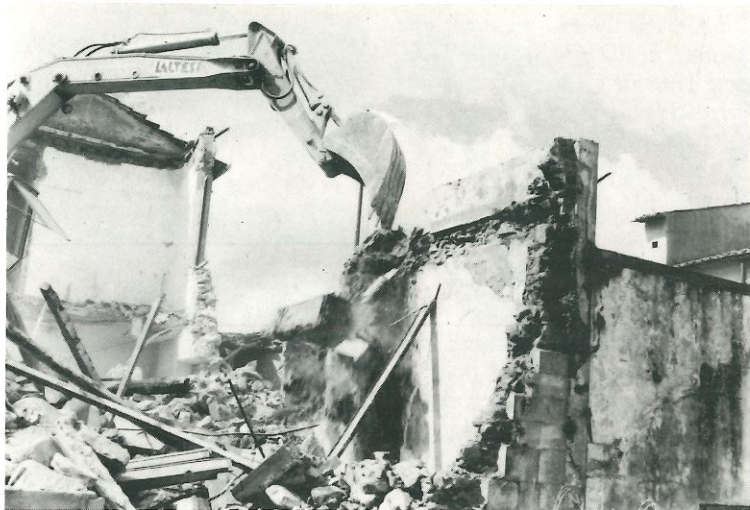
In alto la demolizione della ex Casa del Popolo (foto Della Bella)
