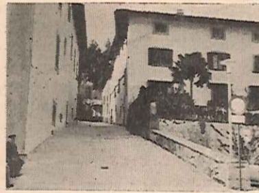
Pavimentazione in Via S. Francesco
