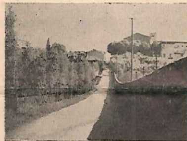
La Via Badia - S. Domenico bitumata
